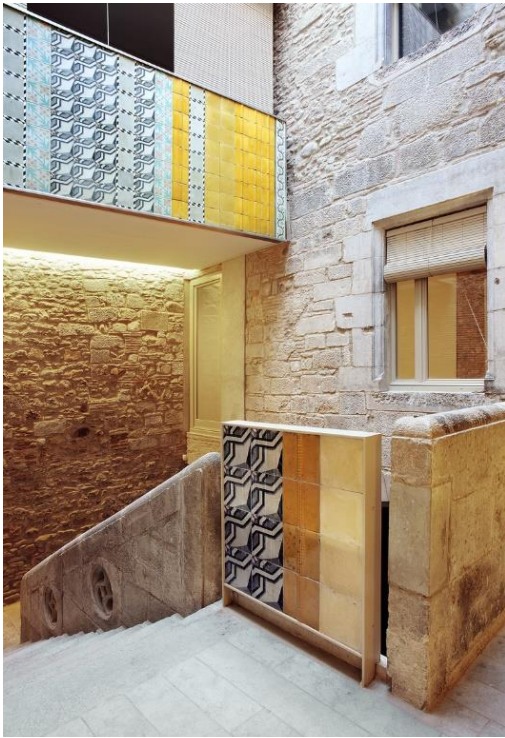
3 Siège de l'Ordre des Architectes. Ancien bâtiment médiéval connu sous le nom de La Sopa (Aide aux affamés). Architectes Cervera-Pla-Moner
